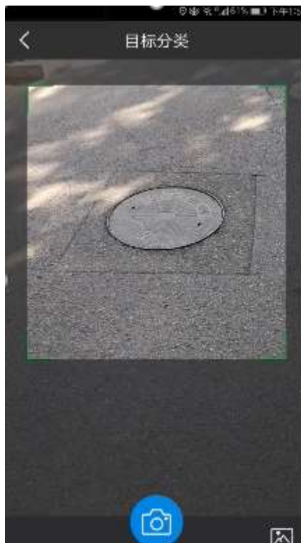
路上のマンホール
